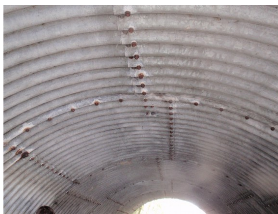
Boulonnerie corrodée
